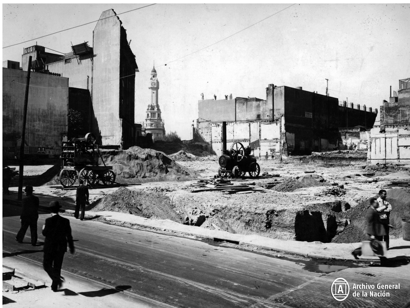
Demoliciones para el trazado de Diagonal Sur, Julio A. Roca. Buenos Aires, 1937. Archivo General de la Nación. Inventario 64019.
